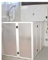
L'installation de **pompe de relèvement** ou pompe à eau permet d'obtenir un accès de plain pied lorsque l'installation d'un siphon de sol n'est pas possible, ce système permet d'aspirer l'eau rapidement.
