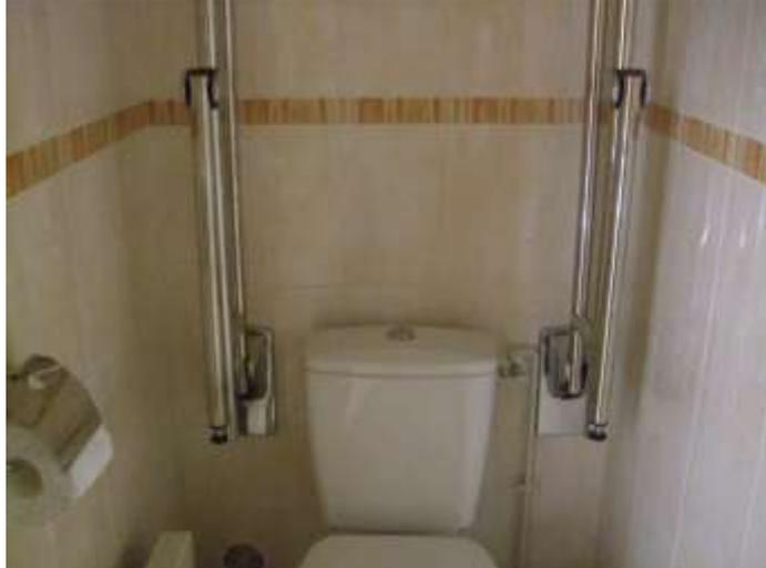
*Barres d'appui levier pour WC (position relevée)*
