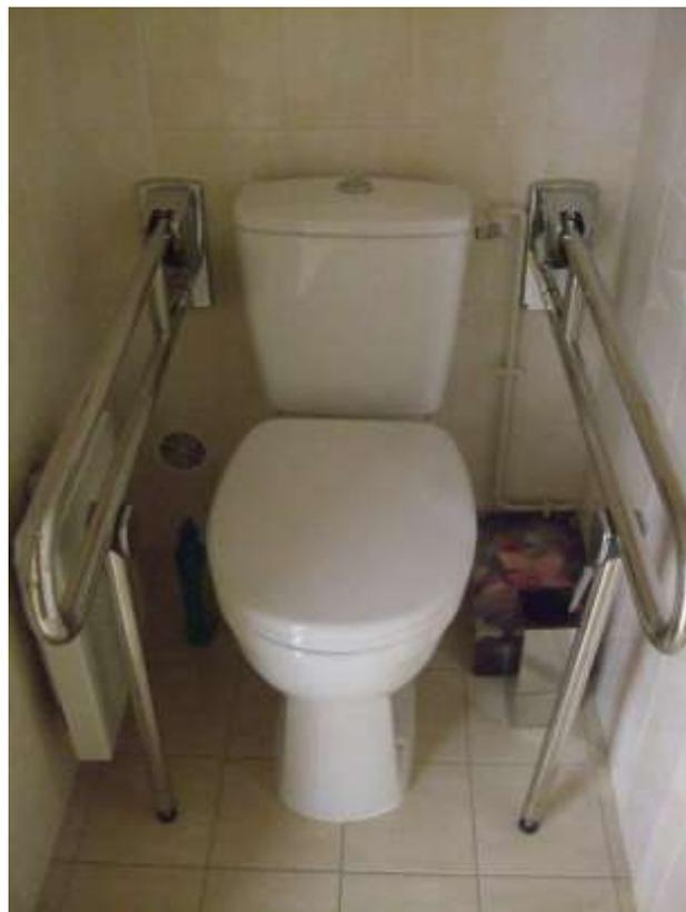
*Barres d'appui levier pour WC (position baissée)*
